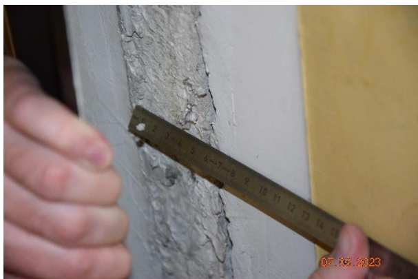
Slika 3-6 Dilatacija v osi 13
