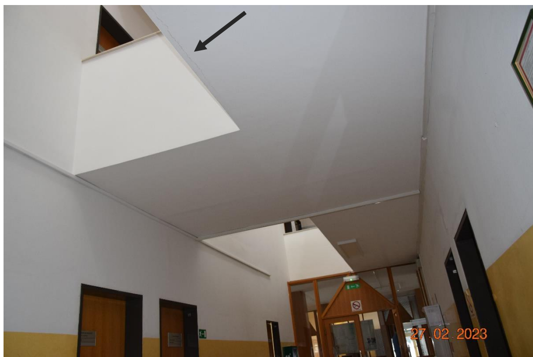
Slika 3-3 Razpoka na AB plošči
