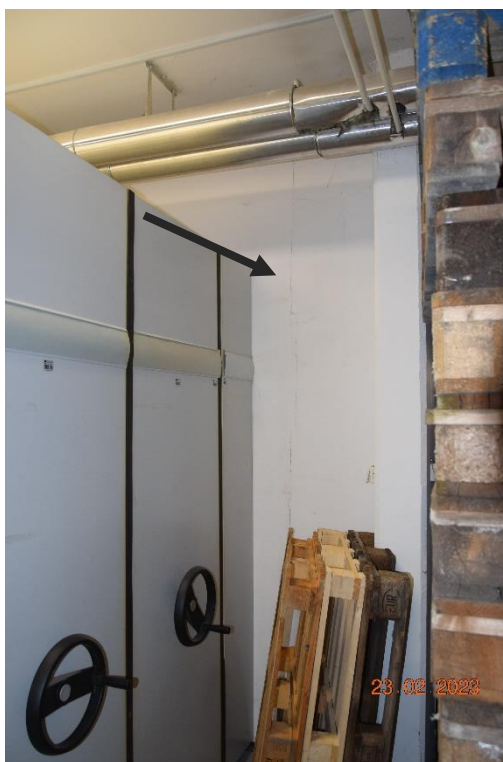
Slika 3-2 Vertikalna razpoka na dilatacijski steni
