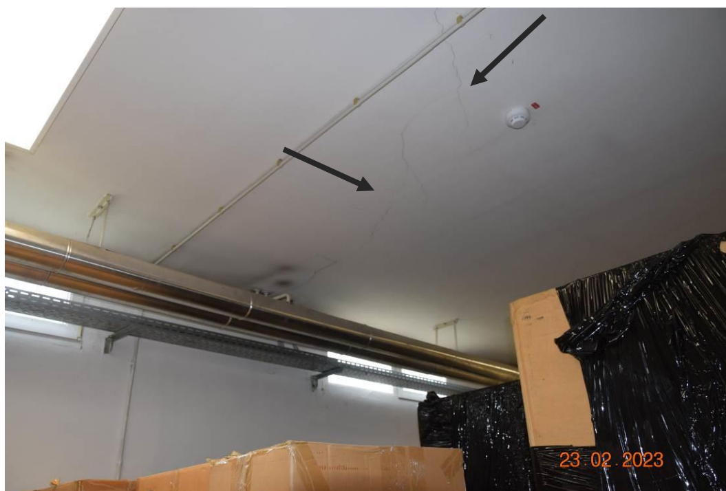
Slika 3-1 Razpoke na AB plošči
