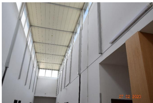
Slika 3-9 Jekleni profili svetlobnika
