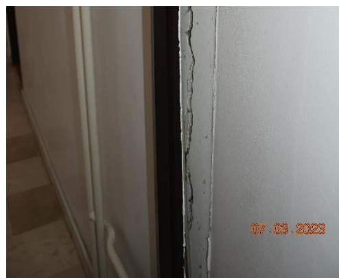
Slika 3-7 Dilatacija v osi 6
