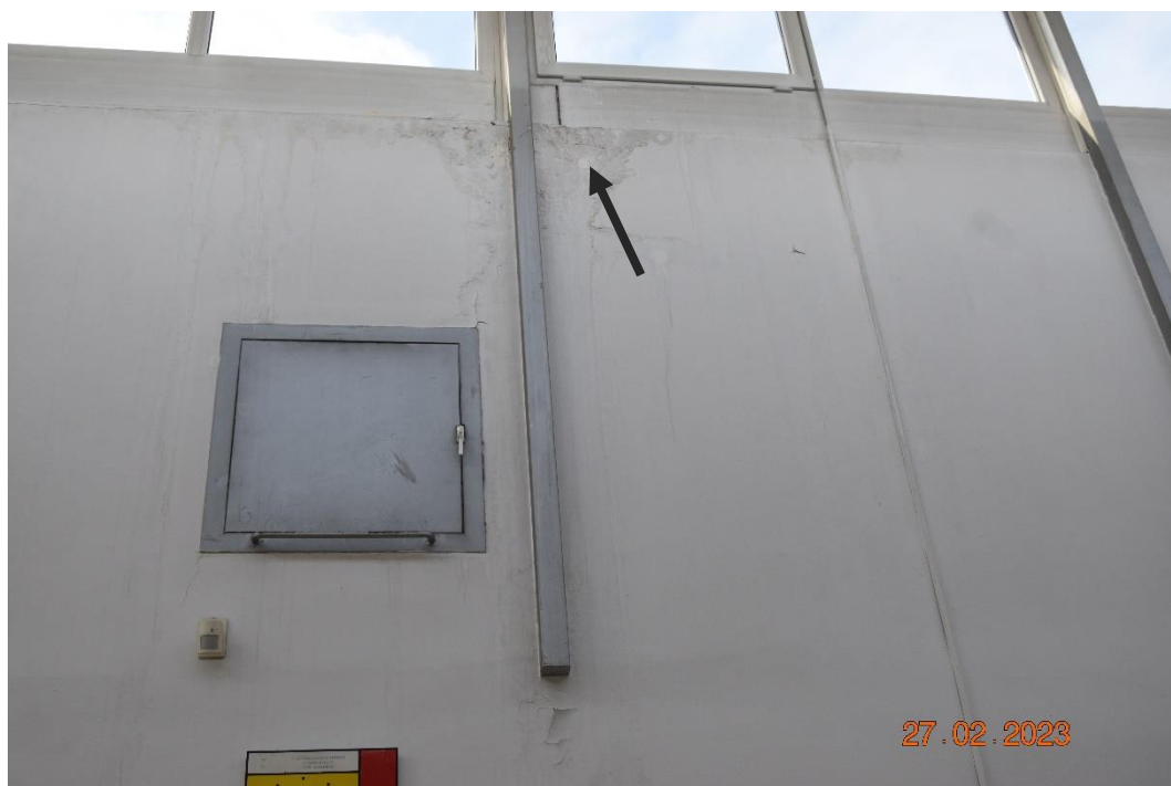
Slika 3-5 Zamakanje pri jeklenem profilu svetlobnika
